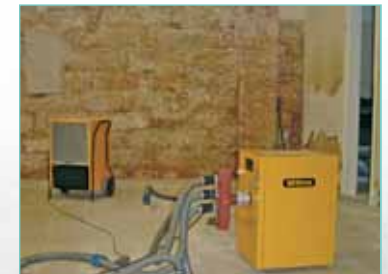
[Trocknung eines Hochwasserschadens]
