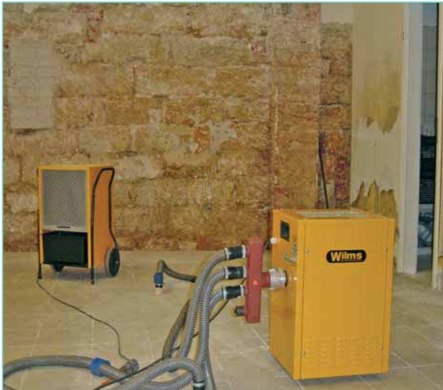
[Trocknung eines Hochwasserschadens]
